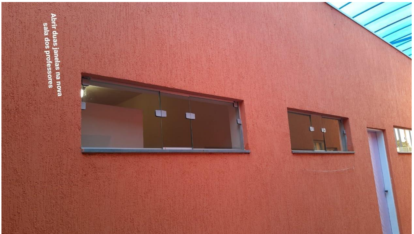
Imagem 12 – Atual parede externa da sala dos professores com as janelas que serão rebaixadas e instaladas novas janelas com tamanho padrão de acordo com a planilha orçamentária e com o projeto arquitetônico.
