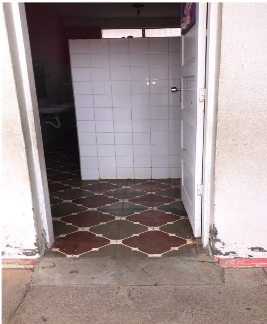
Foto 2 – Portas que não atendem a NBR 9050
