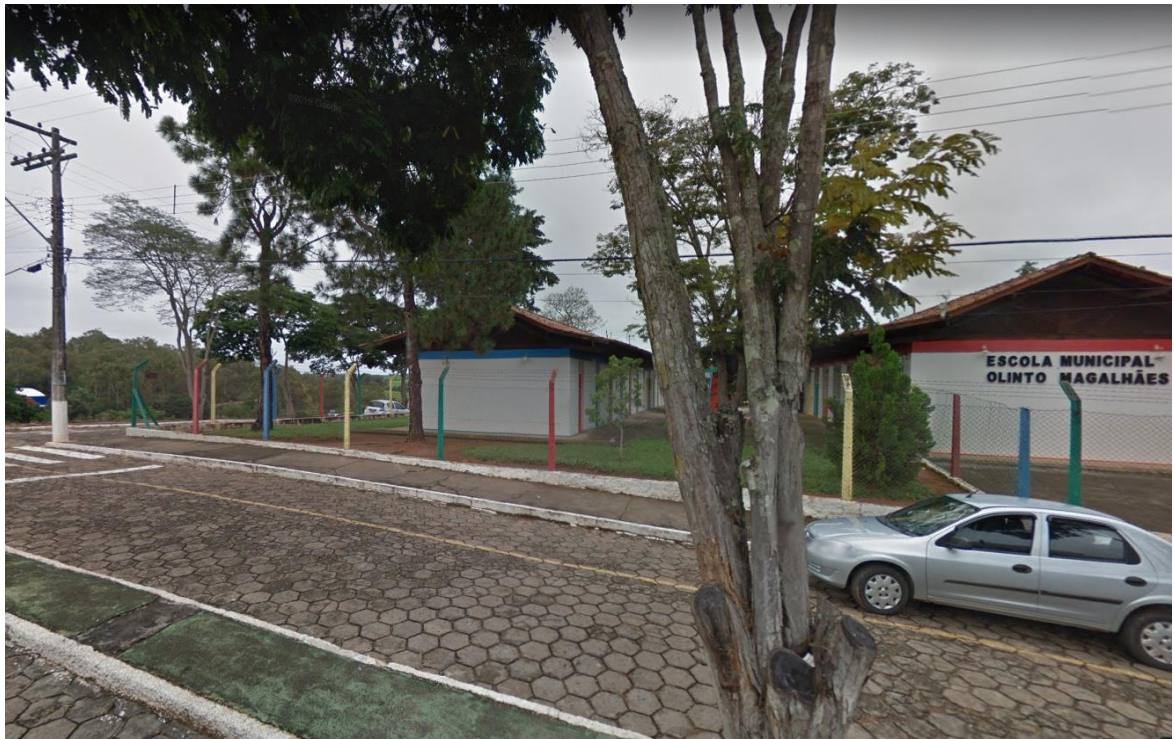
Foto 01 - Bloco 1 e Bloco 2 - Escola Municipal Olinto Magalhães
