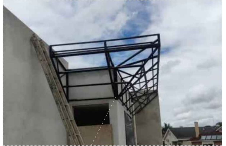
BEIRAL EM ESTRUTURA DE METALON APOIADO NA VIGA
