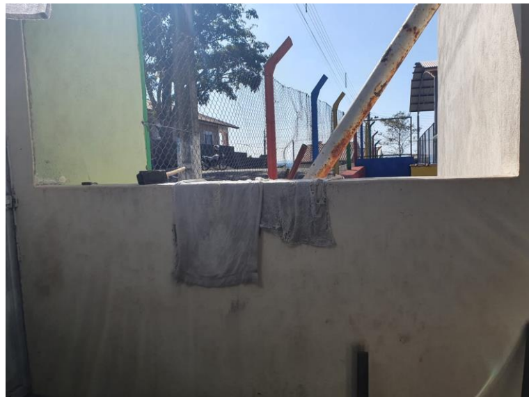
IMAGEM 11 – DEMOLIÇÃO DE ALVENARIA – LOCAL DESTINADO A NOVA LAVANDERIA
