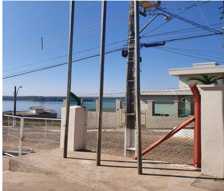
IMAGEM 15 – REMOÇÃO DO MASTRO
