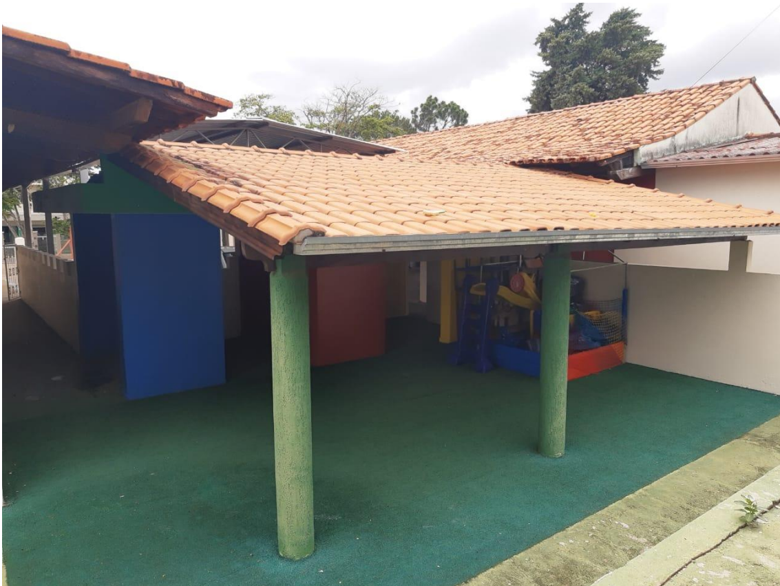
Foto 08 – Telhado existente no local que será reaproveitado
