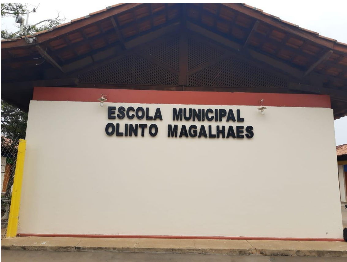
Foto 09 – Local a ser realocado o telhado de cerâmica existente
