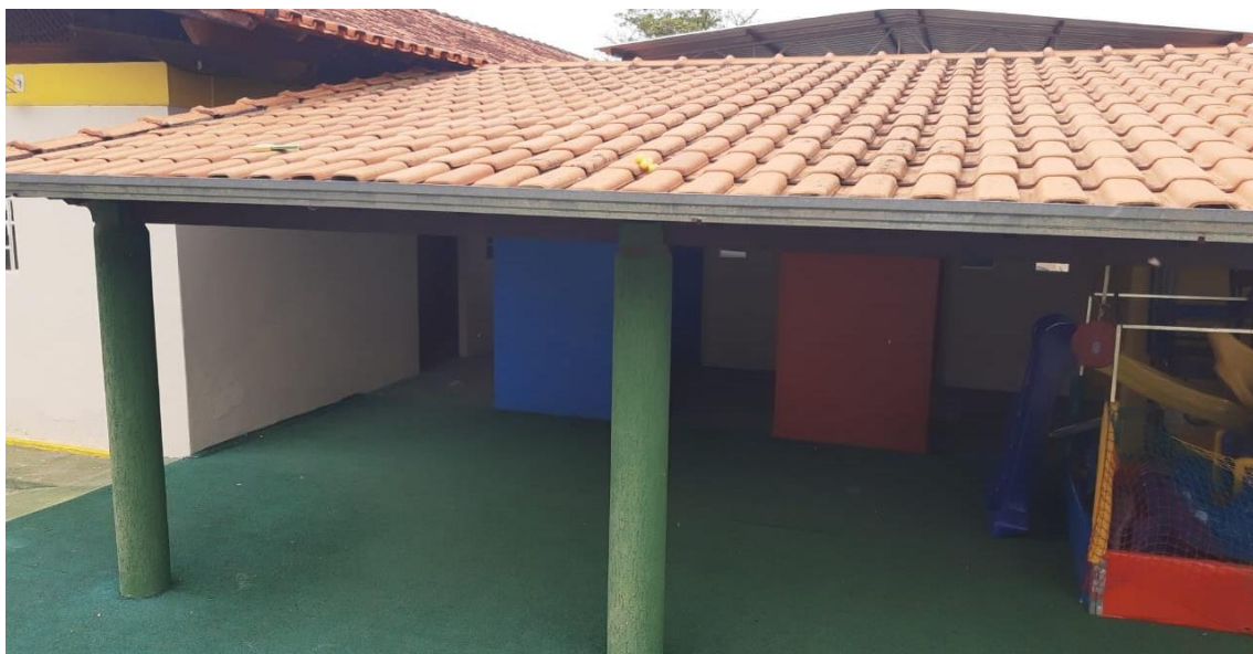
Foto 07 – Telhado existente no local que será reaproveitado
