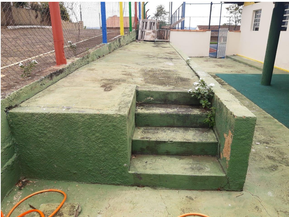
Foto 03 – Mureta existente no local
