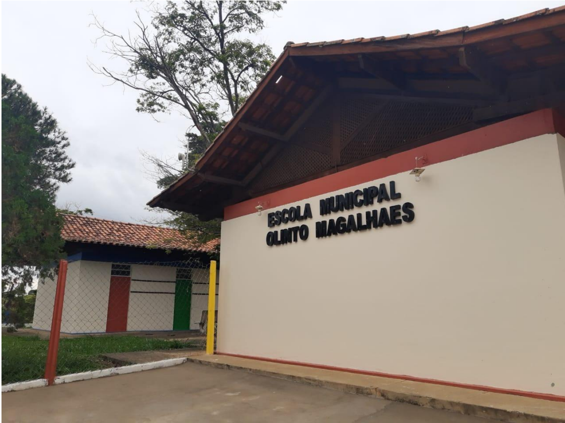
Foto 10 – Local a ser realocado o telhado de cerâmica existente
