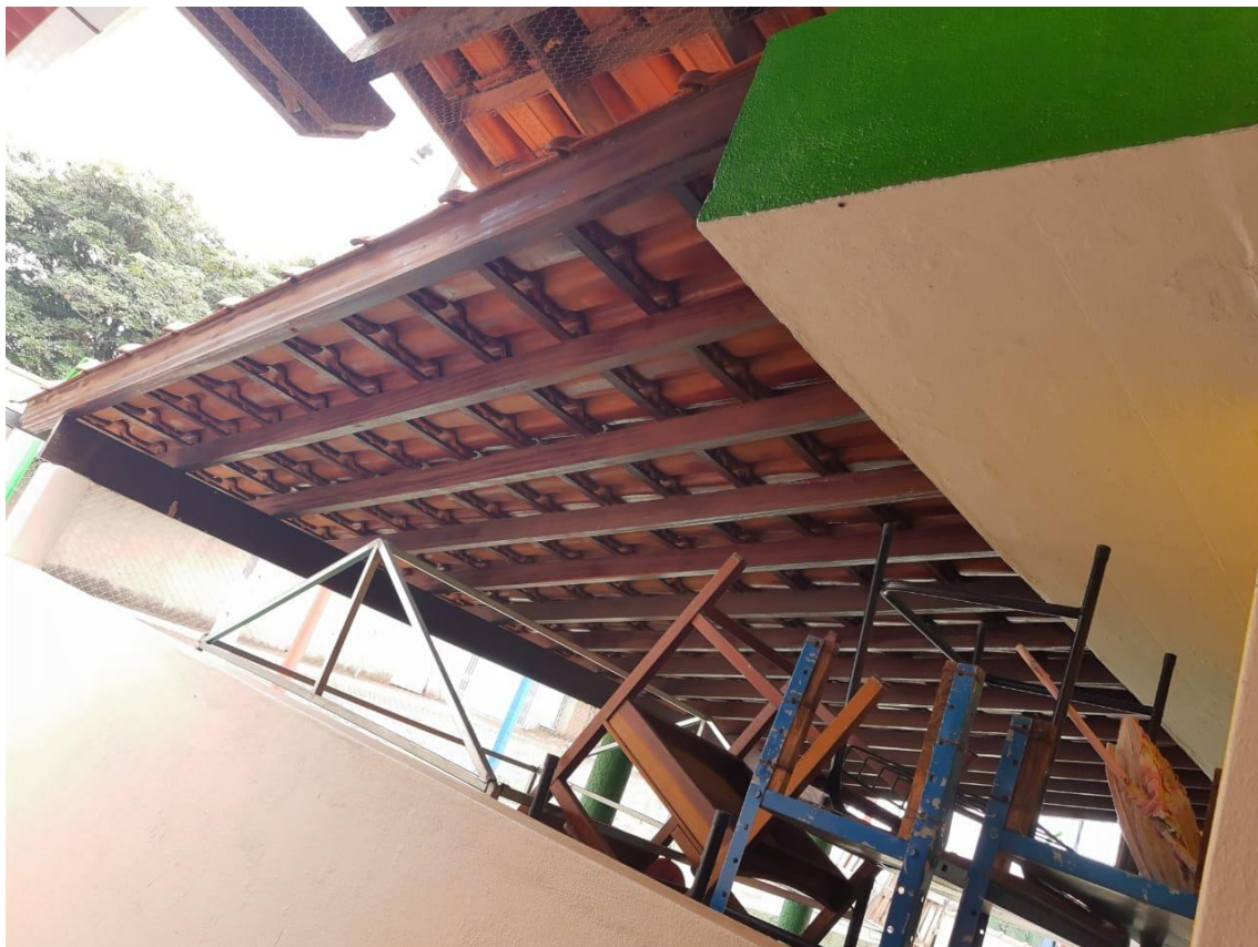
Foto 06 – Telhado existente no local que será reaproveitado
