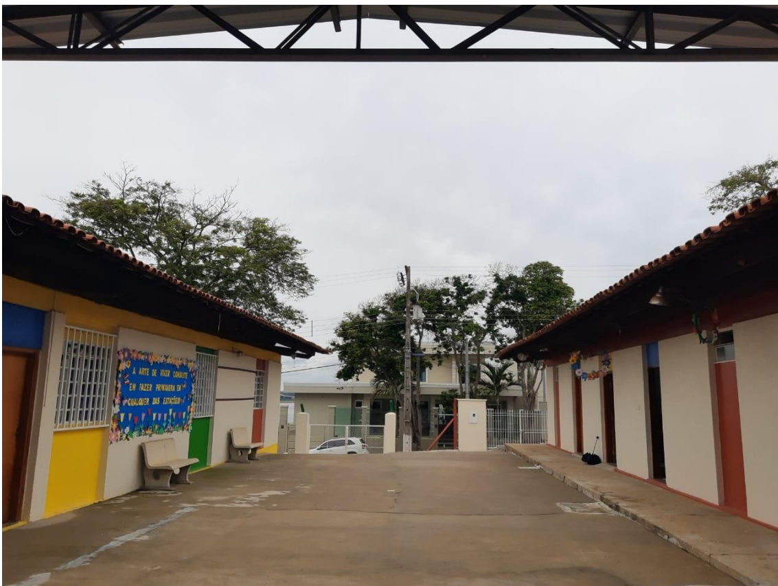
Foto 17 – Espaço à ser instalado a cobertura metálica.
