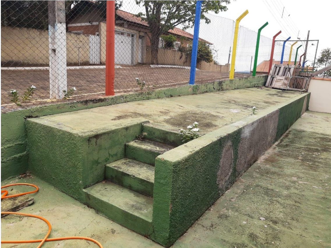
Foto 02 – Mureta existente no local
