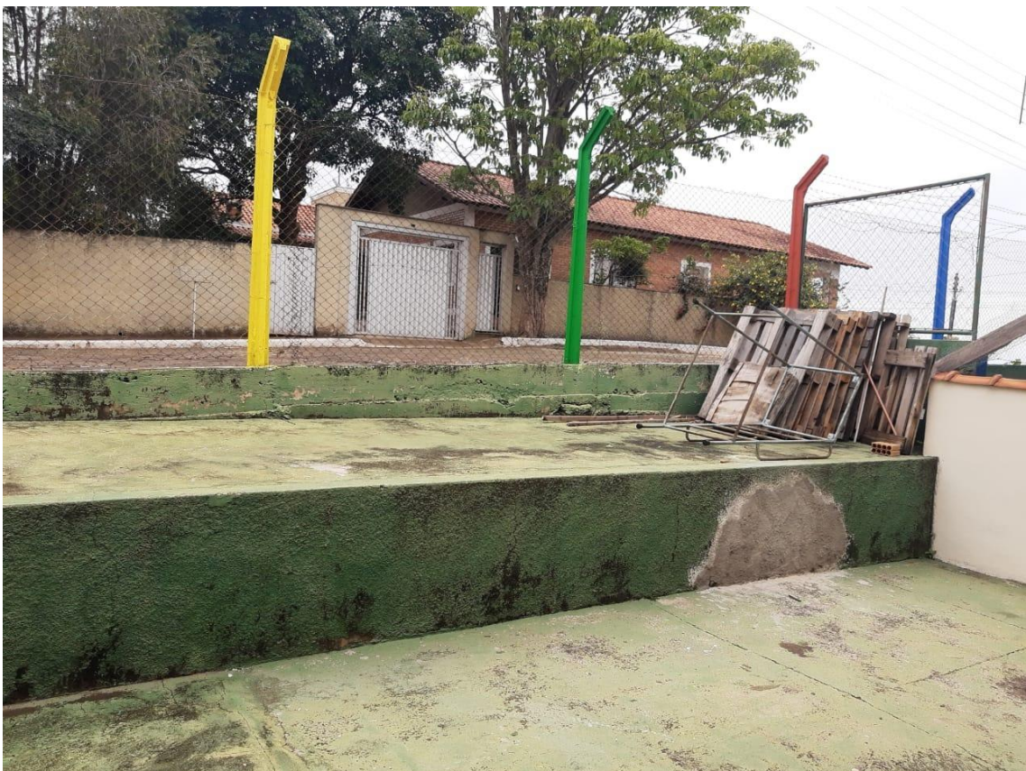
Foto 05 – Mureta existente no local
