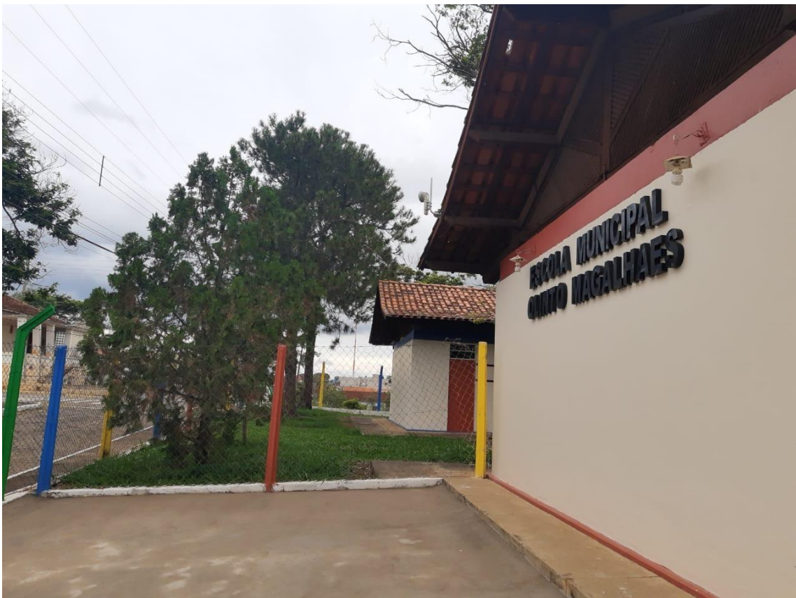
Foto 11 – Local a ser realocado o telhado de cerâmica existente
