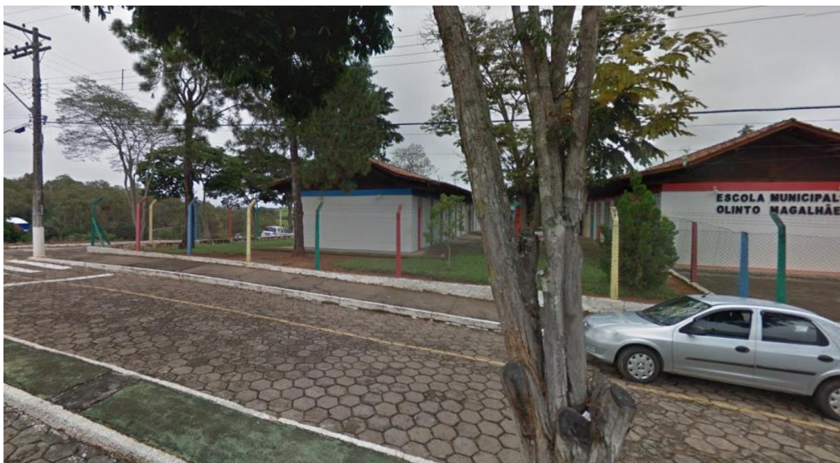
Foto 01 – Bloco 1 (um) e Bloco 2 (dois) – Escola Municipal Olinto Magalhães
