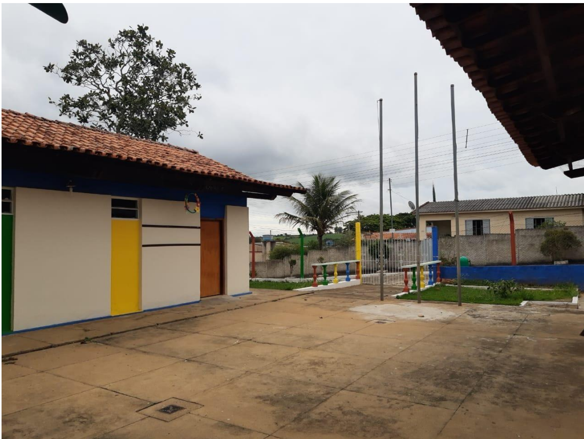
Foto 19 – Uns dos espaços a ser instalado a cobertura metálica.
