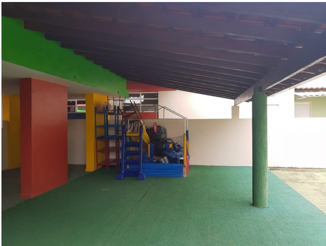
Foto 12 – Local à ser executado a sala e lavabo.
