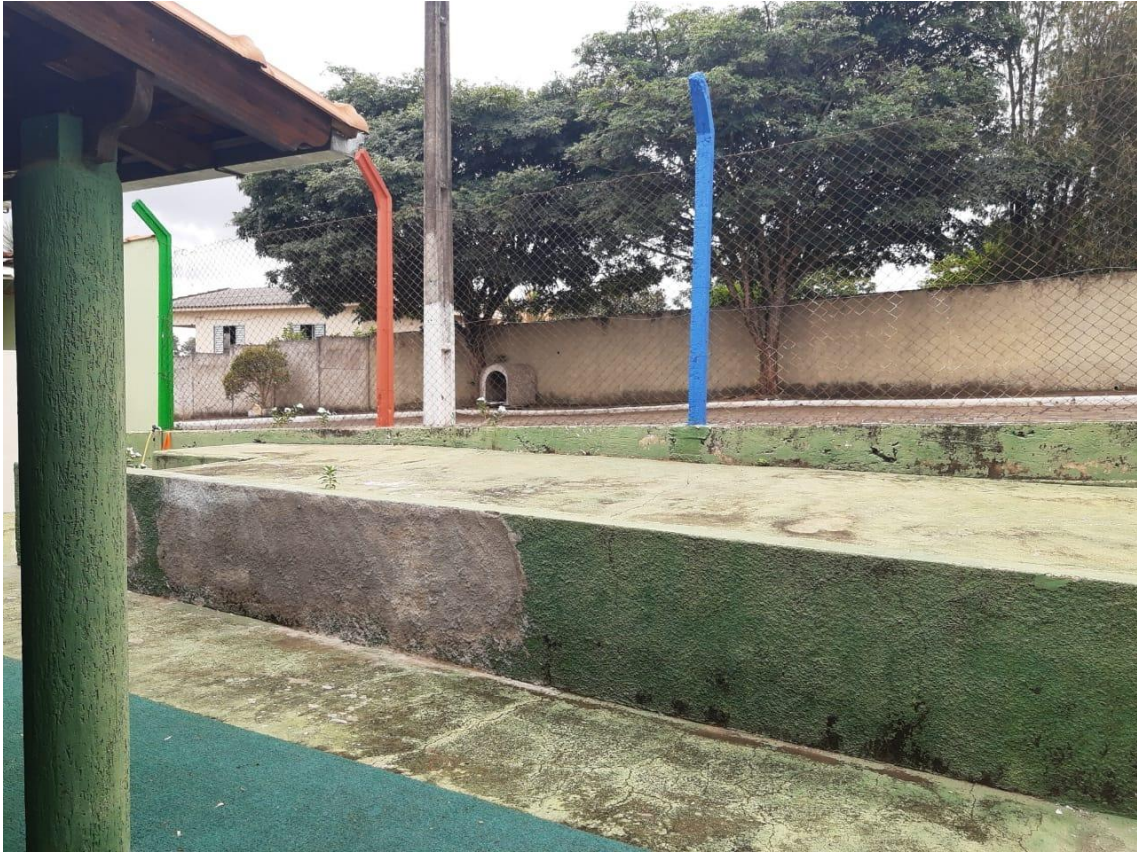
Foto 04 – Mureta existente no local
