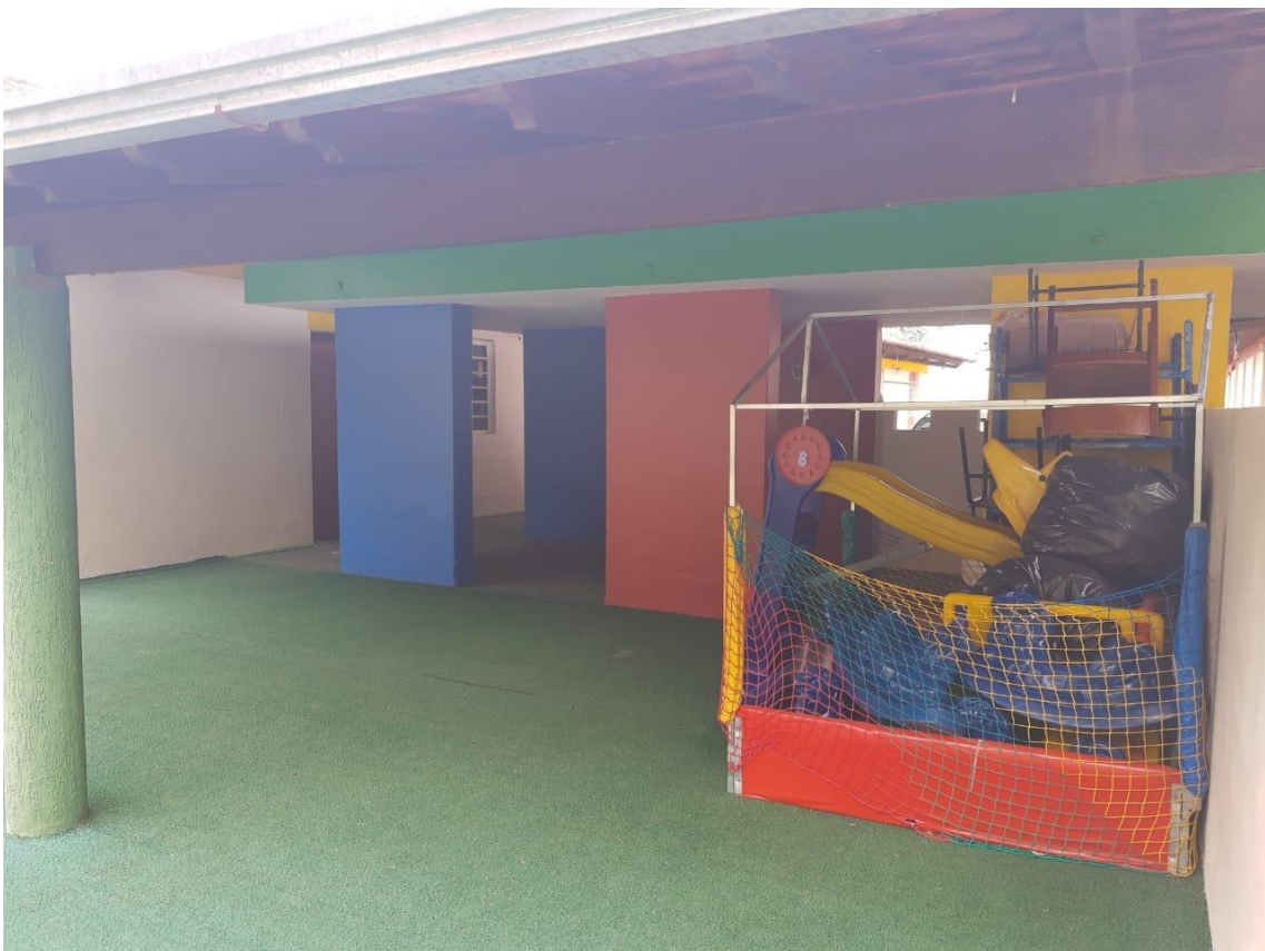
Foto 14 – Local à ser executado a sala e lavabo.
