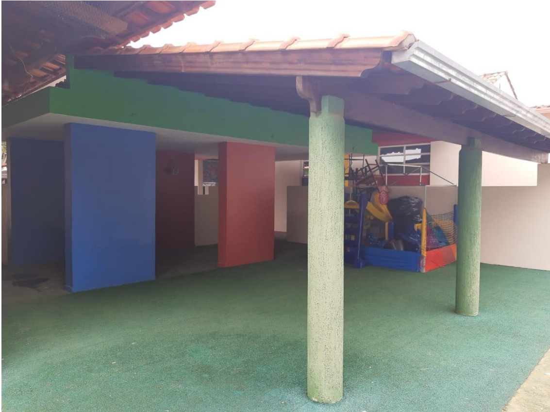
Foto 15 – Local à ser executado a sala e lavabo.
