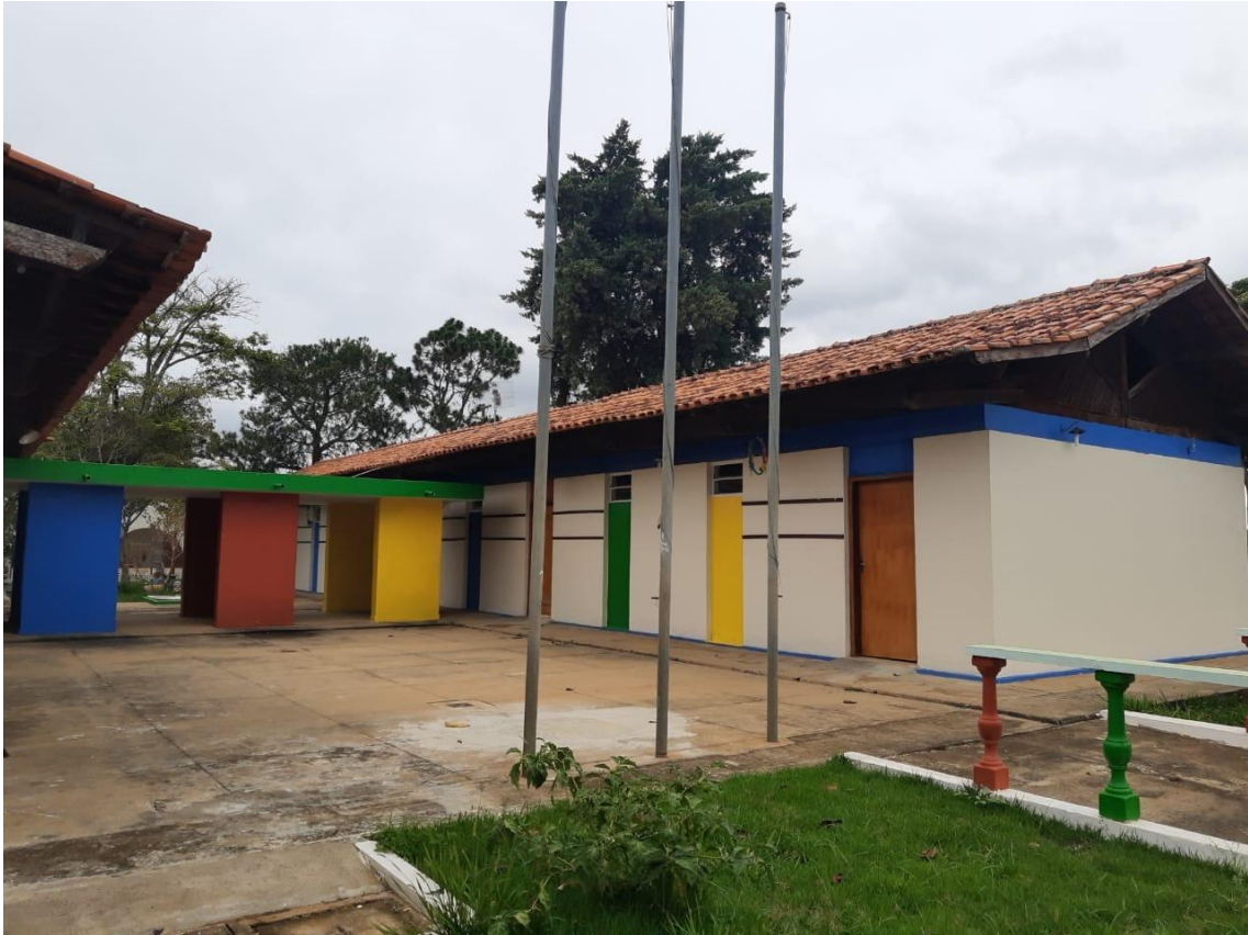
Foto 18 – Uns dos espaços a ser instalado a cobertura metálica.
